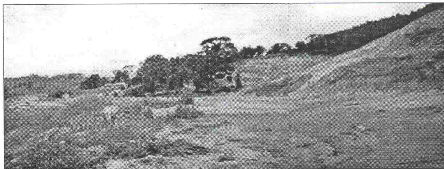
Figura 4: Vista lateral de acesso ao Aterro Sanitário
