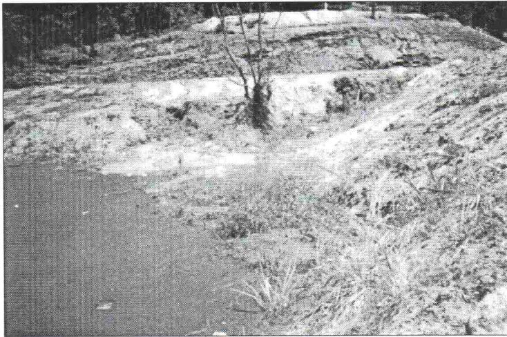
Figura 2: Vista parcial da Lagoa, com deslizamento no entorno.
